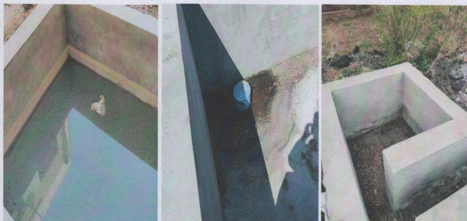
1#: 皂化渣库渗滤液出口
