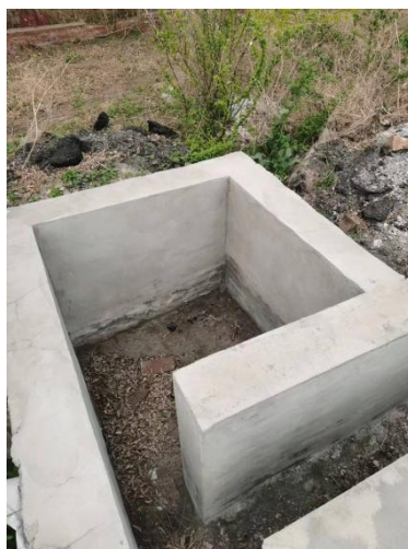
皂化渣库渗滤液收集池
