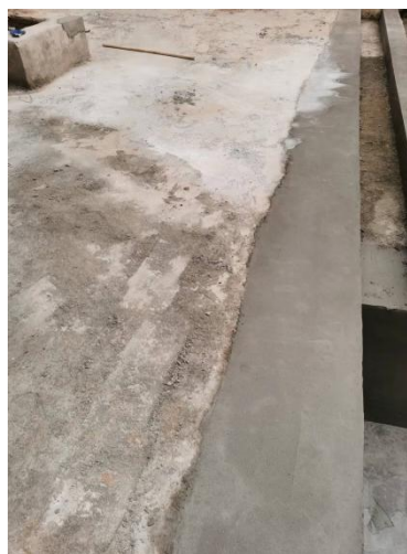
皂化渣库导流渠
