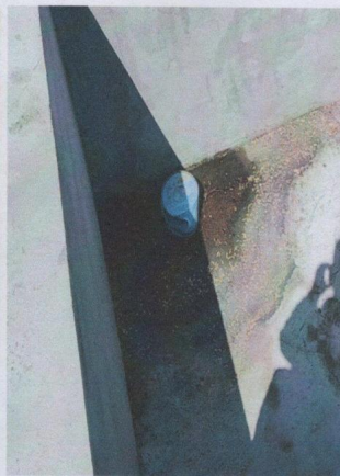
2#: 盐泥库渗滤液出口
