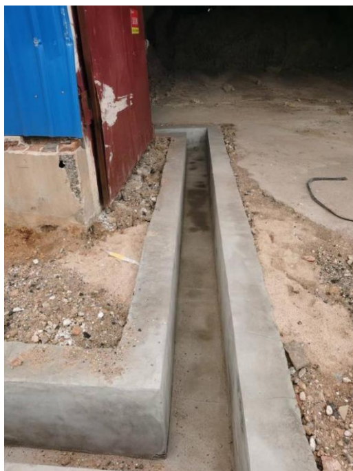
盐泥库渗滤液导流渠
