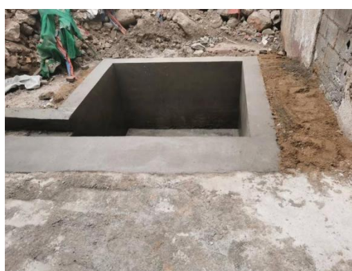
皂化渣库渗滤液收集池
