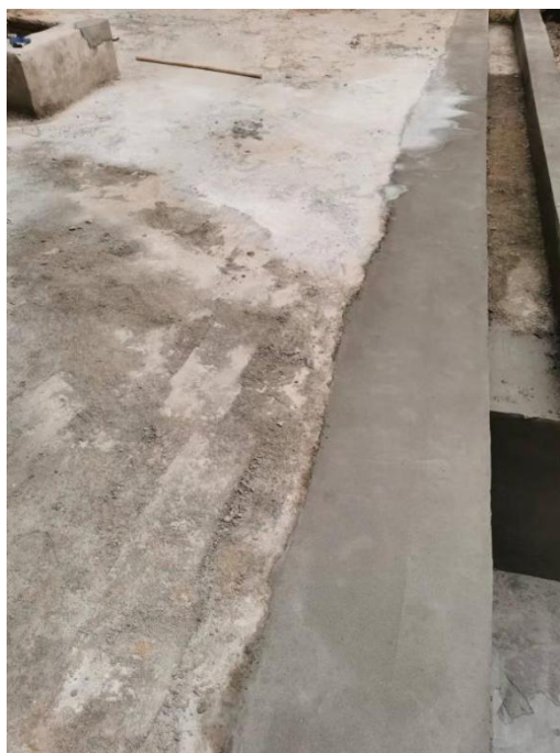
皂化渣库导流渠
