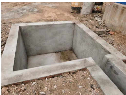
盐泥库渗滤液收集池
