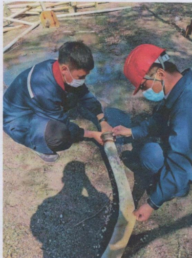
地下水检测现场照片
